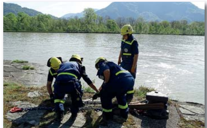
Am Festpunkt 1 wird das Stahlseil quer über den Inn gespannt.
