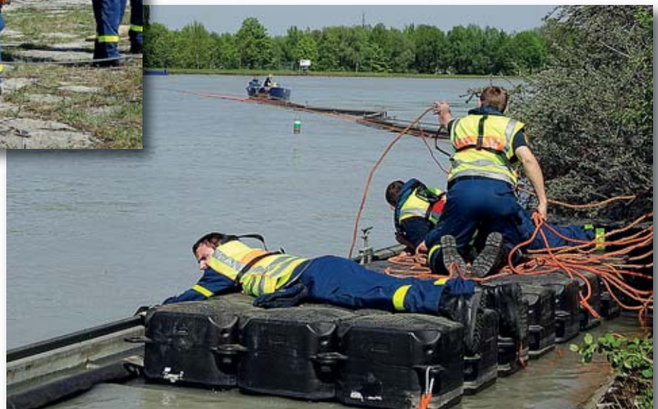
Am Festpunkt 1 wird das Stahlseil quer über den Inn gespannt.
