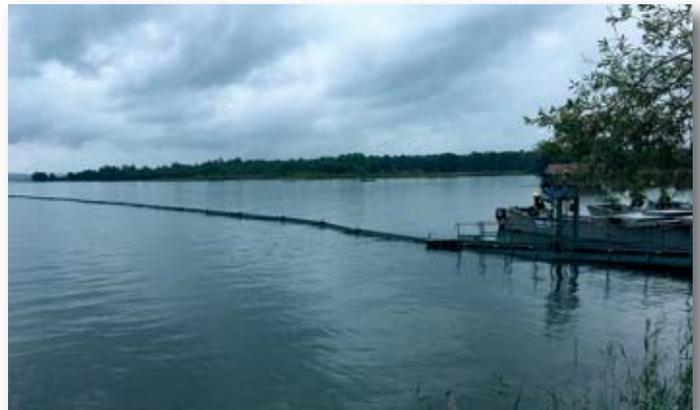
Die Ölsperren werden in einzelnen Segmenten auf dem Chiemsee eingebracht.
